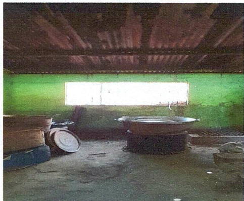
Foto 1: Mejoramiento, reparación o sustitución de área de cocina
