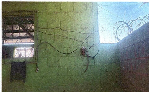
Foto 3: Mejoramiento y reparación de Sistema Eléctrico
