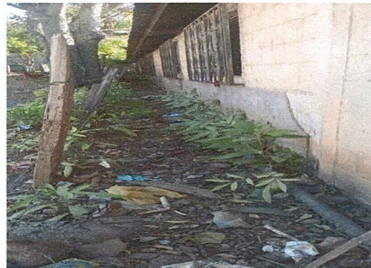
Foto 2: Mejoramiento de cuneta de concreto
